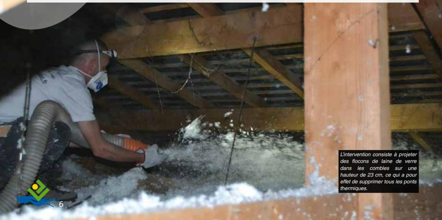
L'intervention consiste à projeter des flocons de laine de verre dans les combles sur une hauteur de 23 cm, ce qui a pour effet de supprimer tous les ponts thermiques.
